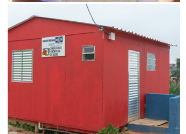
Mit einer Ausbildung zur Baufachkraft werden Favela-Bewohner in São Paulo zum eigenen Hausbau befähigt.
